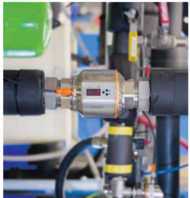
適用於過濾系統飲用水測量的電磁流量計。
